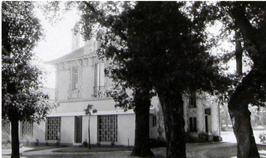
Maison provinciale rue Lacanau, Bordeaux
