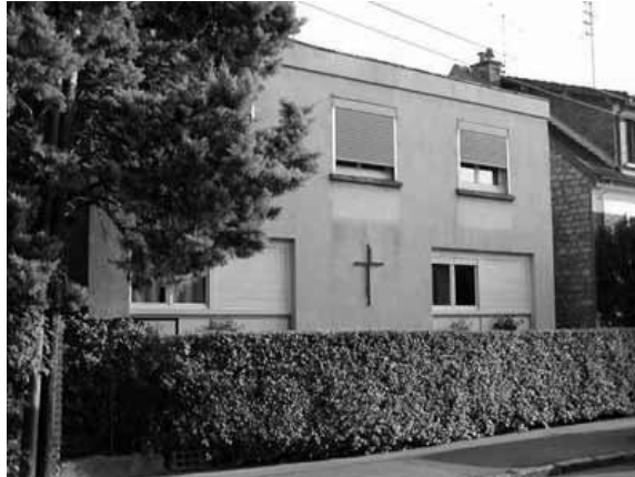
Maison de Cachan, rue de la Marne
